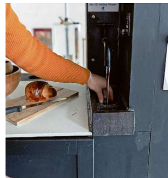
Kein Trinkwasser: In diesem Schüttstein können Kompostreste hinuntergespült werden.
