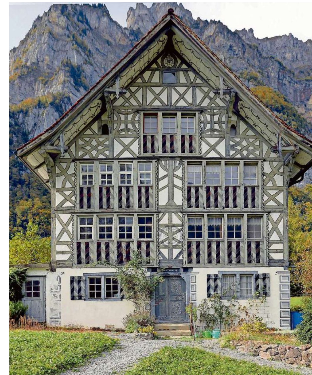
Baudenkmal von Bedeutung: Das Stählihaus in Netstal ist eines der im Kanton Glarus seltenen Riegelhäuser.
